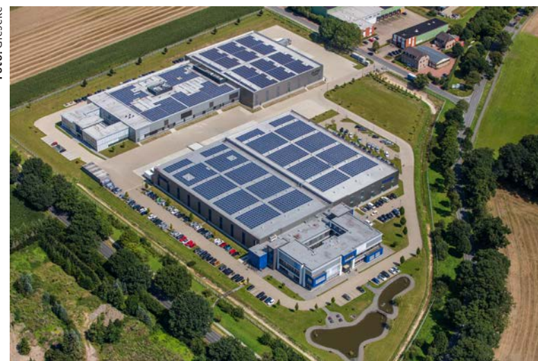
Seit 2016 erzeugt Gieseke Strom mit der eigenen Solaranlage
